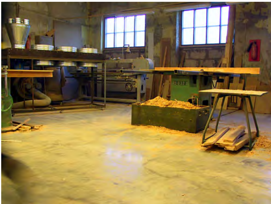
4.Att. Cietbetona grīda uzņēmumā Otto Koks.
