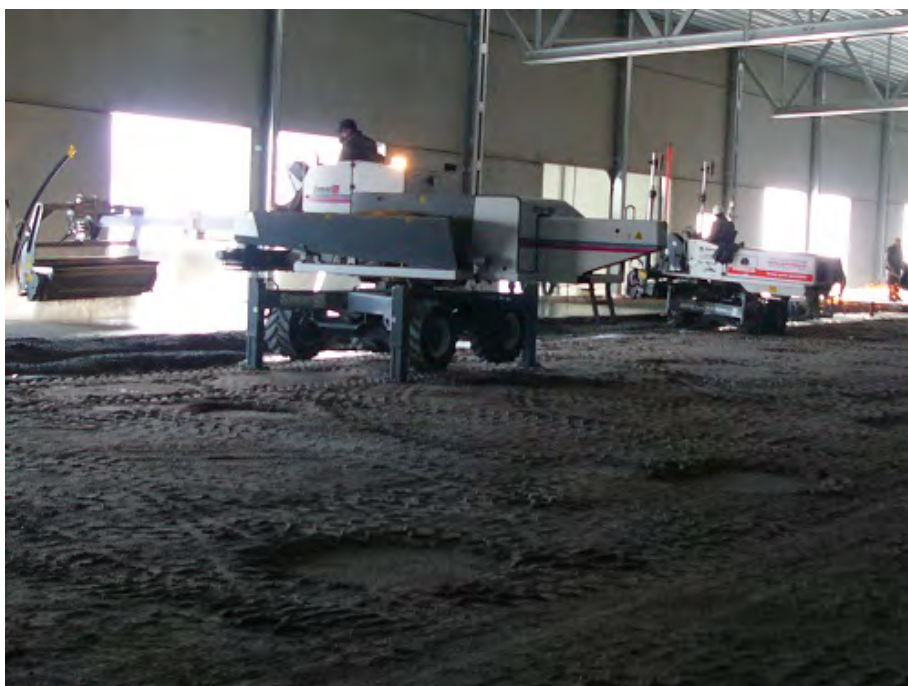
2.Att. Uz pāļiem balstītas grīdas.
