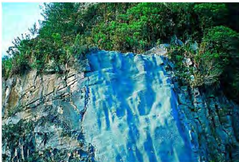
1.2.6. att. Ar fibrobetonu noklāta klints [28]
