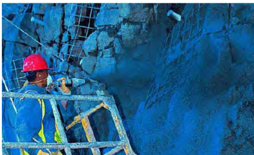
1.2.5. att. Klints noklāšana ar fibrobetonu [28]
